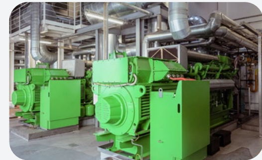
Foto: Warmtekrachtkoppeling
